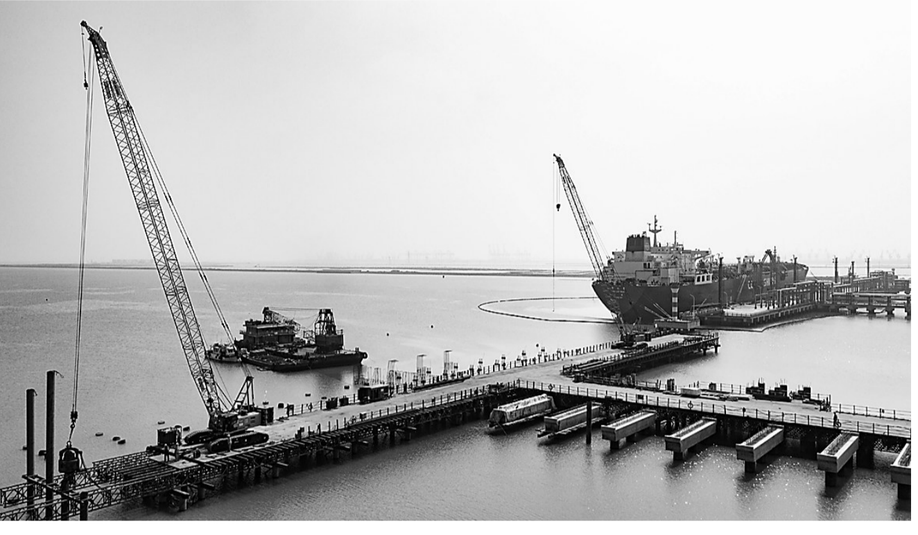
黄骅港综合港区液体化工码头钢栈桥施工项目正在加快建设。据了解,该项目位于黄骅港综合港区二港池,将建设1个5万吨级液化烃泊位和1个2万吨级液体化工泊位及后方配套库区,码头设计年吞吐量427万吨,泊位设计年通过能力470万吨,陆域面积39.4万平方米。马玲 付秀智 孙晓卉 摄
