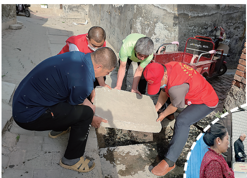
▲热心居民自发维修破损沟盖板。
