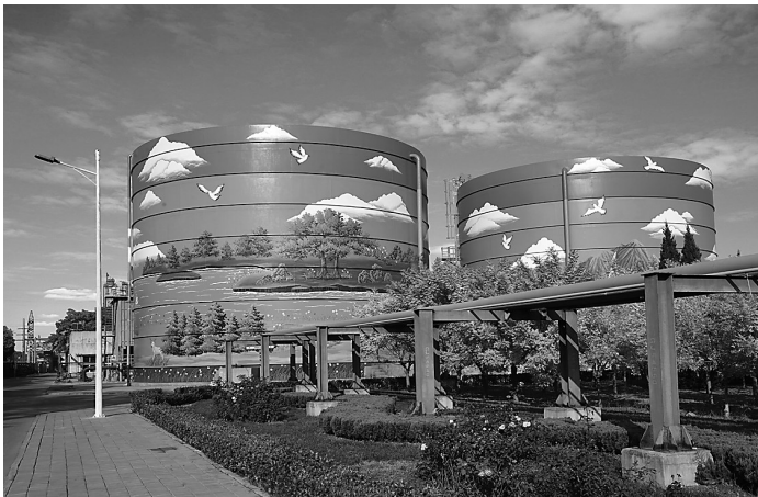
日前，中国石化沧州炼化公司为装置区内的消防水罐、烟囱“穿”上了漂亮的“外衣”，一幅幅绚丽多彩的图案，传递着企业绿色环保的发展理念。 伏铁刚 张 婷 摄
