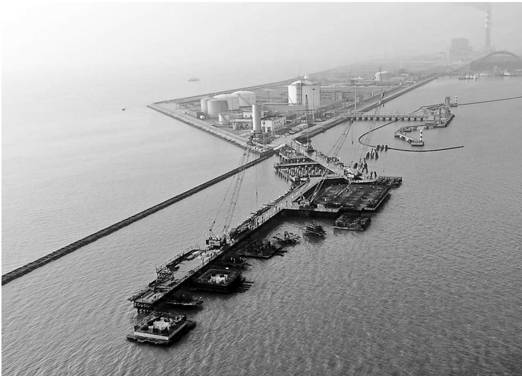
11月20日,国能黄骅港务有限责任公司油品码头工程施工人员正在进行墩台混凝土浇筑作业,码头施工全面进入“快车道”。据了解,该项目将建设1个8万吨级油品泊位及相关生产生活辅助设施,主要承担渤海湾及南海海洋原油上岸的运输功能,预计2026年5月完工。付秀智 摄
