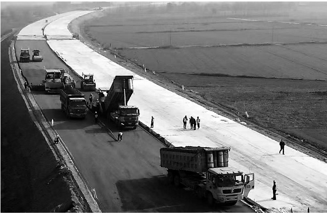
入冬以来，邯港高速沧州段施工现场一派繁忙景象。图为施工人员操作施工设备进行碎石垫层作业。
