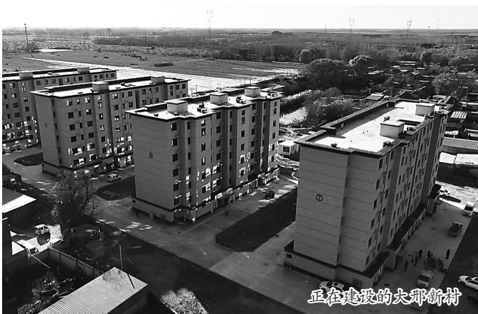
正在建设的大邢新村
