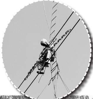
孙波振在220千伏高压线上修补导线
