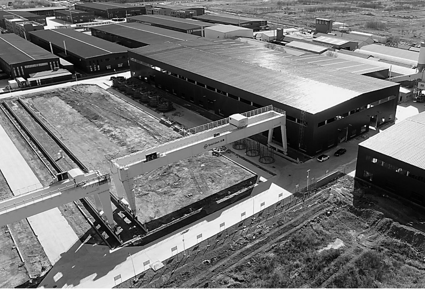
近年来，沧东经济开发区坚持“项目低碳化、产业循环化、园区生态化”的发展理念，加快培育新质生产力，通过打造远景零碳智能产业园、芯安新材料、绿电直供等项目，着力培育一批创新型、协同型、数字化、绿色化、品牌化特色产业集群。
