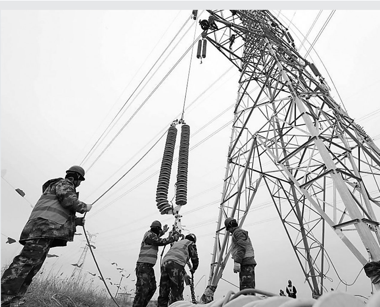
为解决我市沿海地区风电及光伏并网送出问题，国网沧州供电公司持续加快建设大白家220千伏输变电工程，优化电网结构，有效提升区域新能源外送能力，助推经济绿色低碳发展。图为大白家220千伏输变电工程建设工地现场。
