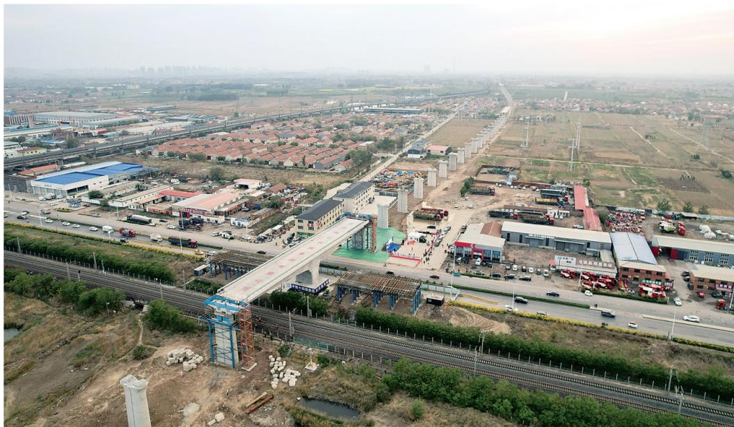
4月22日拍摄的石衡沧港城际铁路跨京沪铁路转体桥(无人机照片)。当日,由中铁十四局集团承建的石衡沧港城际铁路跨京沪铁路转体桥转体完成。该桥位于河北省沧州市沧县姚官屯镇,是全线重点控制性工程。石衡沧港城际铁路是京津冀城市群“四纵四横一环”城际铁路网中的重要组成部分,西起石家庄,东至渤海新区,设计速度250公里每小时。新华社发
