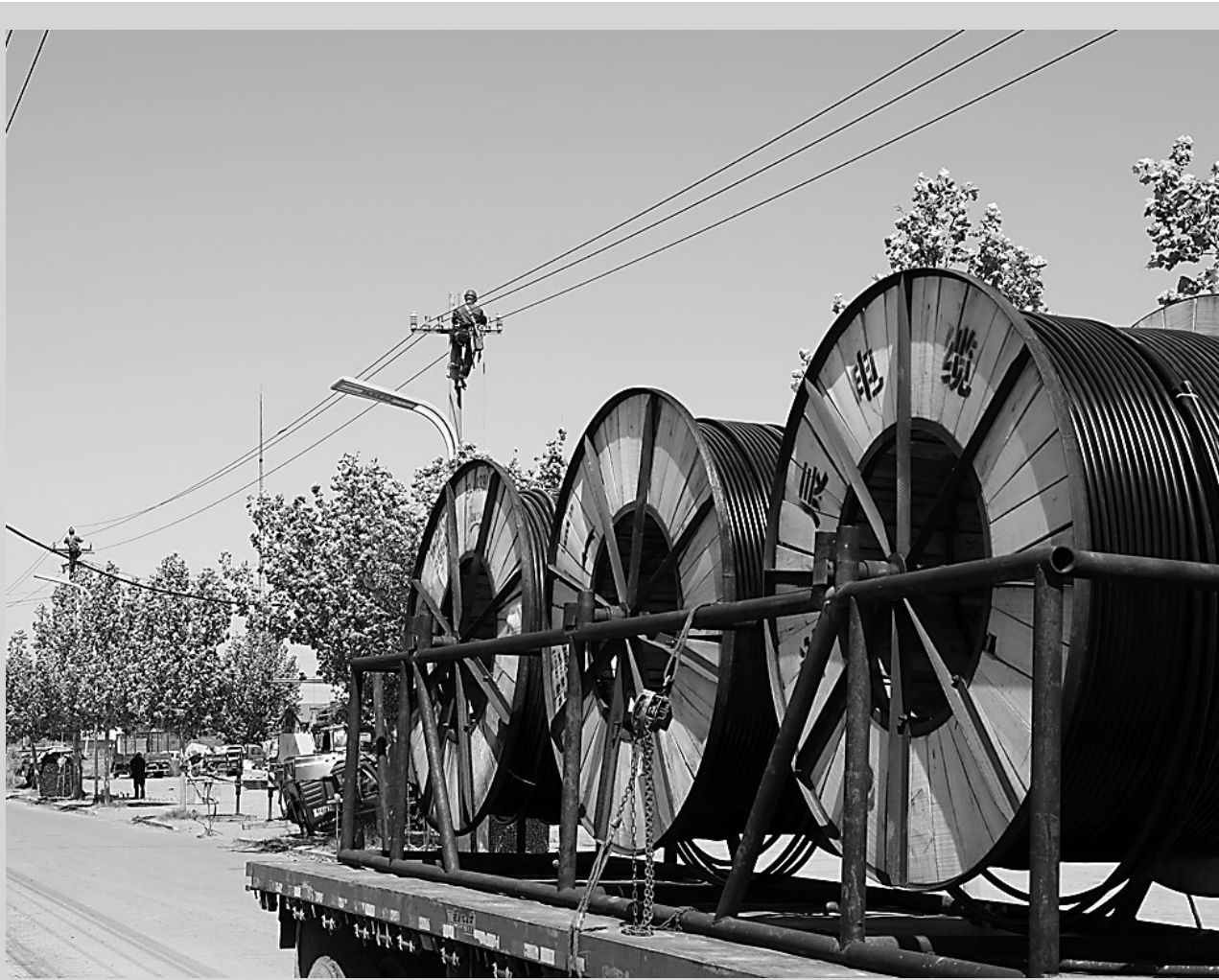
日前，在黄骅吕桥10千伏吕坛5823电力线路改造工程施工现场，中兴集团电力施工人员正在有序开展作业。该项目将通过科学优化线路布局、系统升级电力设备，为当地农田灌溉、农业生产等用电需求提供坚实保障。
