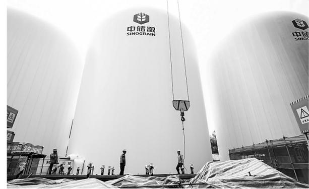
近日,我国首批5座9000吨级气膜粮仓在中储粮长沙直属库充气成型,这标志着我国第四代新型粮仓正式进入实践应用阶段。这是5月6日在中储粮长沙直属库拍摄的气膜粮仓建设施工现场。 新华社发
